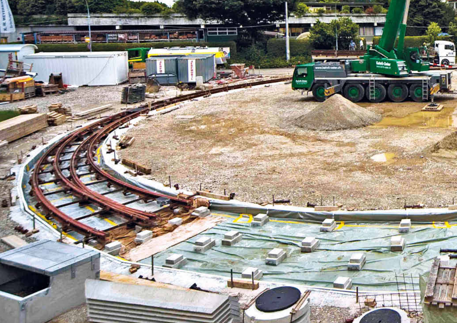
Die Gleisbauer von BERNMOBIL verlegten in etwas mehr als zwei Jahren rund 15 Kilometer Schienen.
